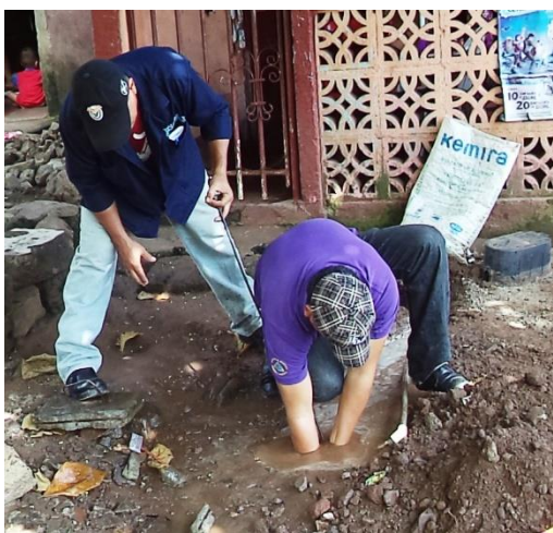
Foto 7: Cortando el servicio de agua con tapón intrusivo
