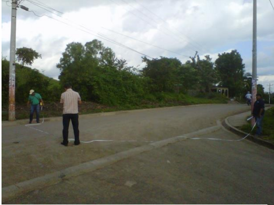
Foto 1: Toma de esquineros en Juigalpa
