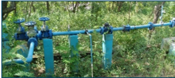
Foto No. 5 Sarta de Pozo 2 pulgadas de diámetro
