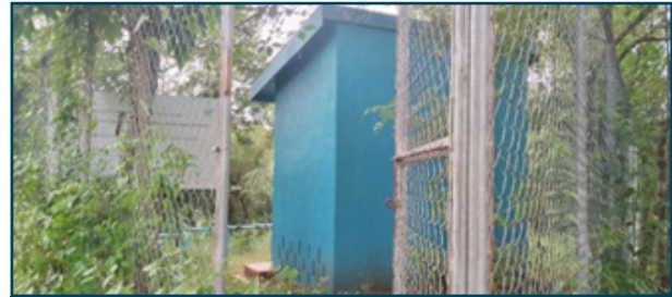
Foto No. 5 Cercos Perimetral de malla ciclón en Pozo
