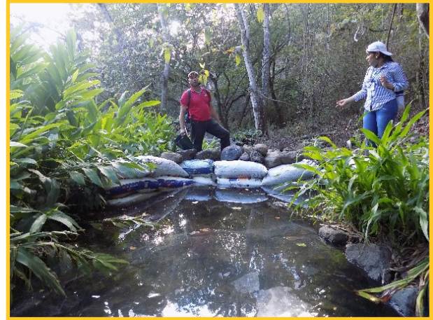
Foto 22: Pequeñas represas hechas con sacos, Quebrada Honda, Las Sabanas
